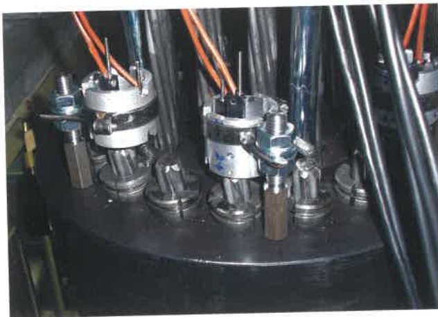
Obr. 2: Měření relativních posunů mezi předpínacími lany a kotvením
