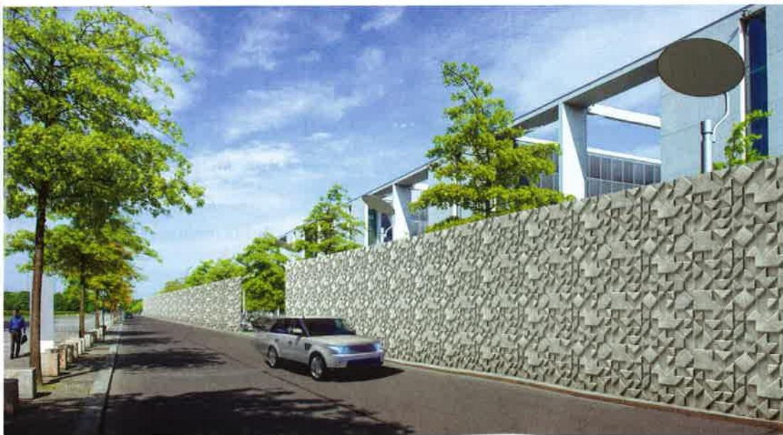
Dekory protihlukových stěn s pohltivou vrstvou z lehčeného betonu
