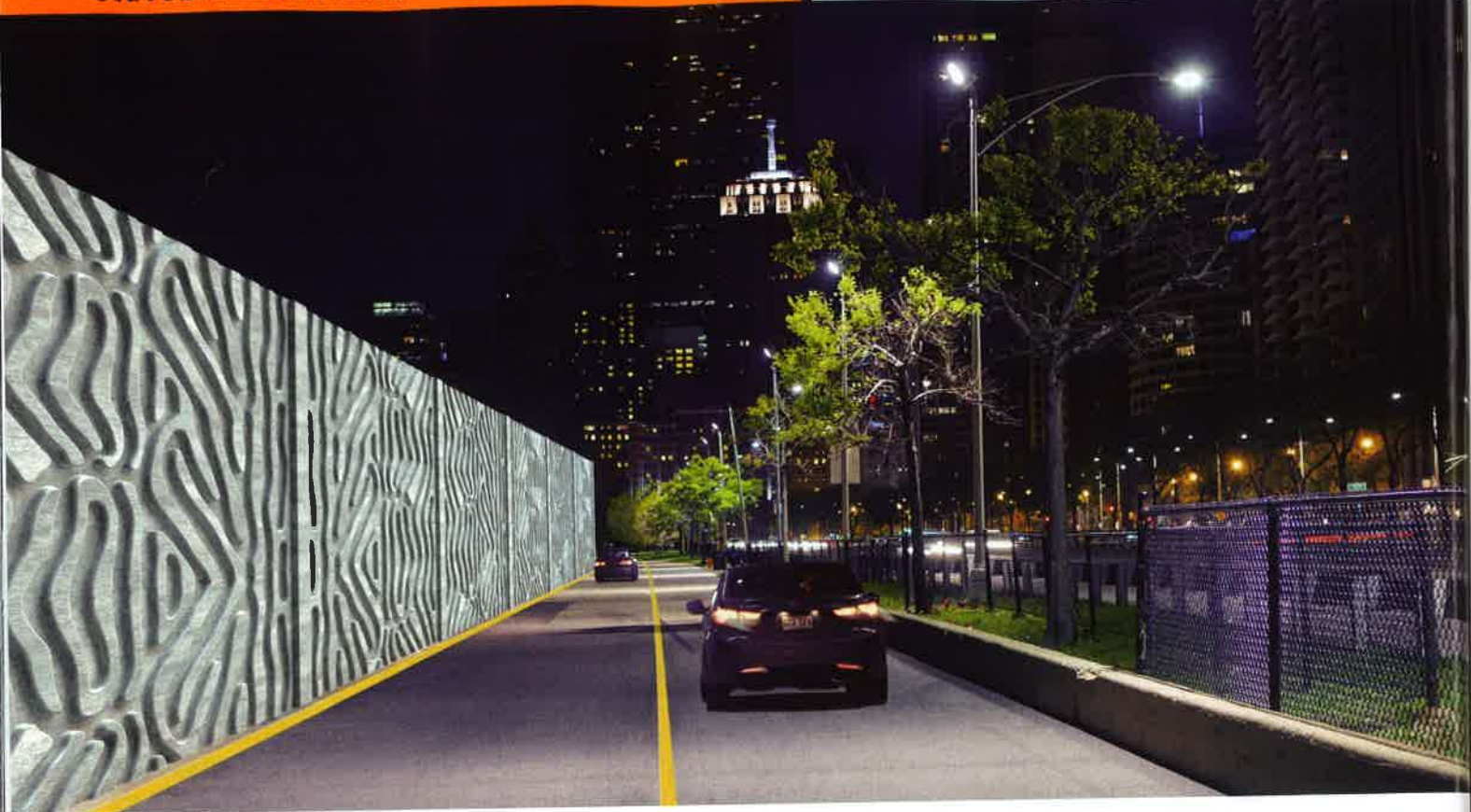
▲ Nový modulární systém protihlukových stěn s pohltivou vrstvou z lehčeného betonu
